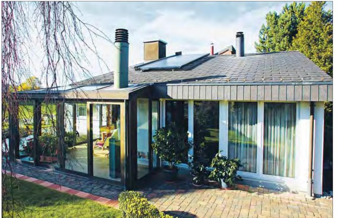
Der Vakuumröhrenkollektor auf dem Schrägdach des Einfamilienhauses der Familie Ruckstuhl dient für die Warmwasseraufbereitung und zur Heizungsunterstützung.
