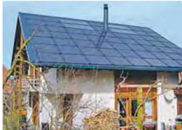
Solardach mit 53 Modulen für die Stromerzeugung und vier Kollektoren für das Warmwasser.
