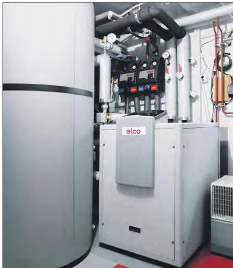
Blick in den Heizungskeller mit der Sole-Wasser-Wärmepumpe Elco Aquatop T10 und dem Kombispeicher der Solaranlage Elco Auron DF.
