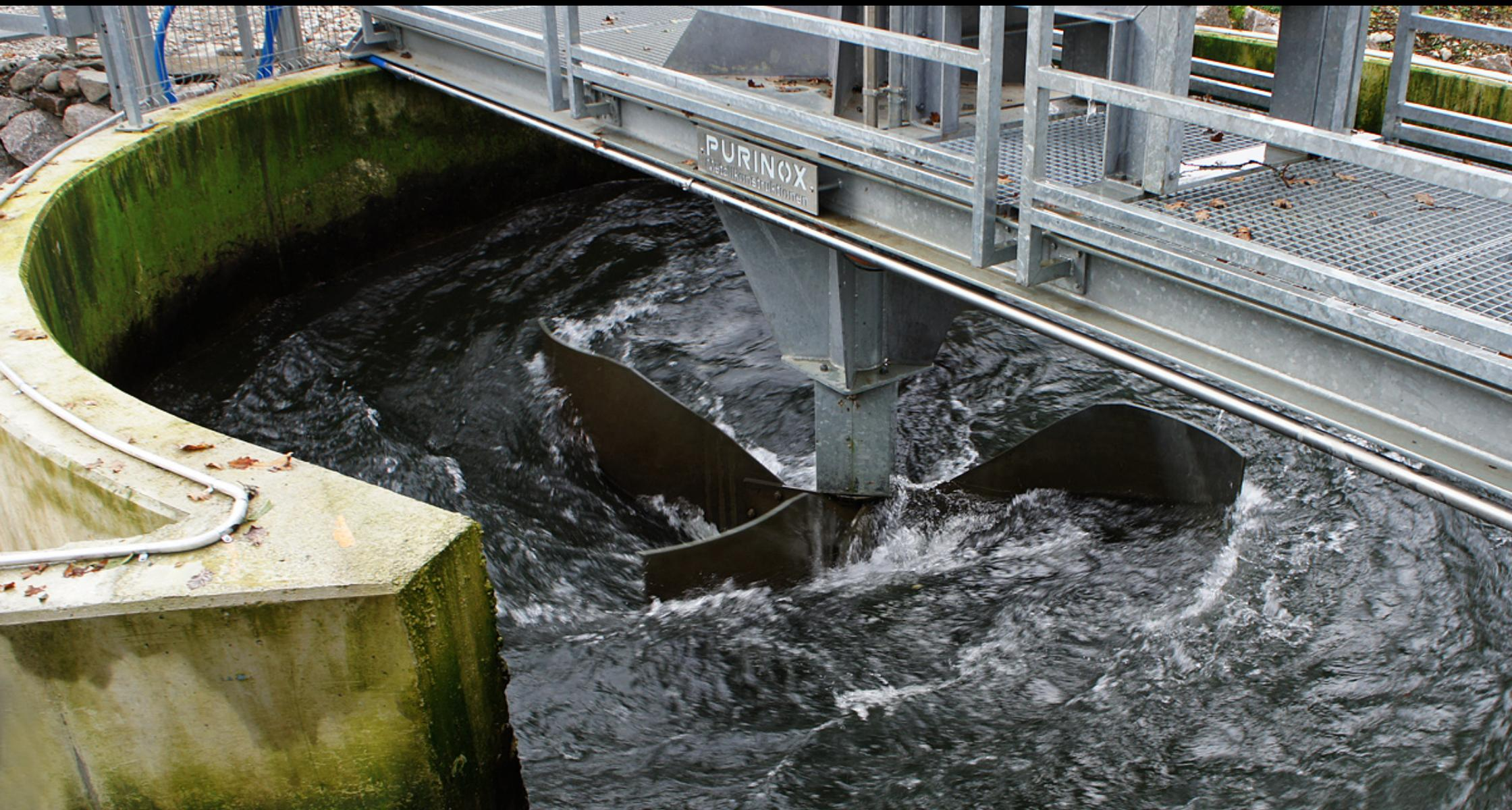
**Flussrenaturierung mit Wasserwirbelkraftwerk**
