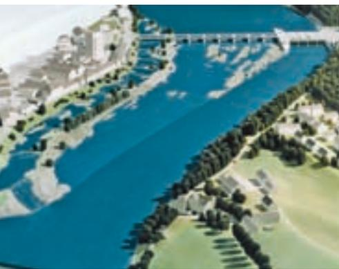
**Modell des neuen Wasserkraftwerks mit dem Aufstiegs- und Laichgewässer sowie den Fischpässen.**
