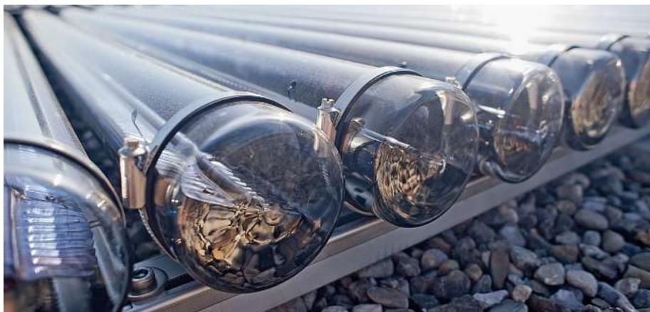
Für die geforderten Temperaturen eignen sich nur Vakuumröhrenkollektoren
