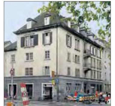
In nur sechs Monaten wurde das Mehrfamilienhaus an der Magnusstrasse 28 in Zürich komplett saniert – samt neuem Dachgeschoss aus vorgefertigten Elementen.
