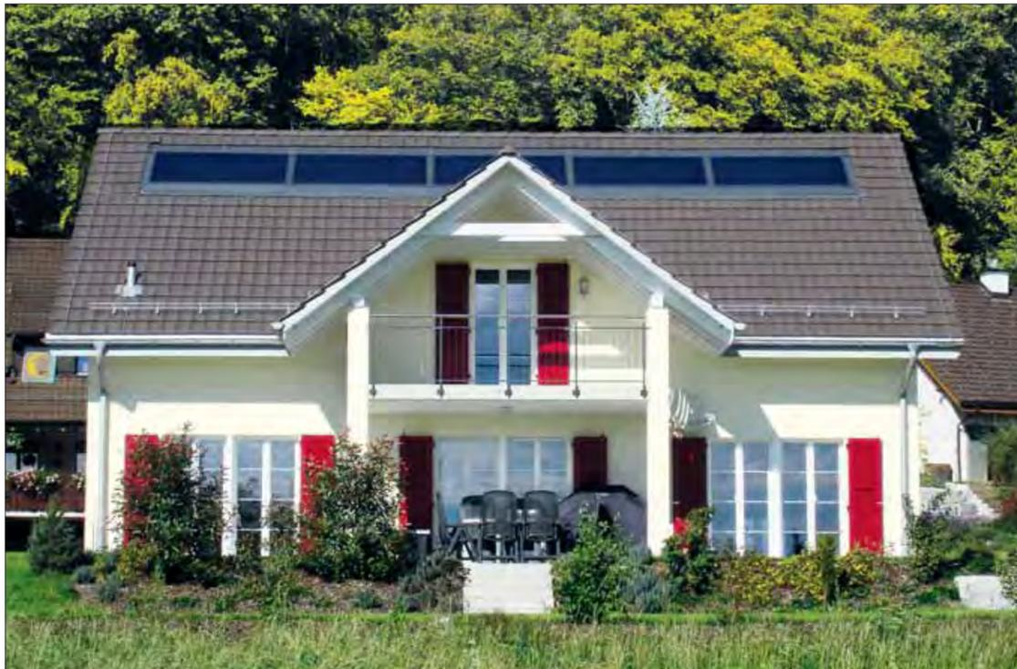
Soll die Anlage auch das Heizungssystem unterstützen, braucht es mindestens 15 Quadratmeter Sonnenkollektoren. Vier bis sechs Quadratmeter genügen jedoch, um 70 Prozent des Warmwasserbedarfs einer vierköpfigen Familie zu decken.
