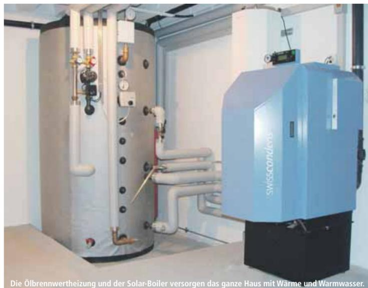
Die Ölbrennwertheizung und der Solar-Boiler versorgen das ganze Haus mit Wärme und Warmwasser.
