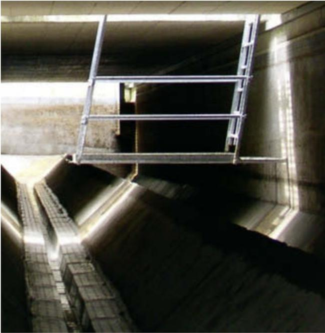
Abb. 4: Absenkbares Besucherpodest über den Wärmetauschern im Regenüberlaufbecken Saarstraße in Bretten (Foto: Hubert Mauz, Uhrig Kanaltechnik)
