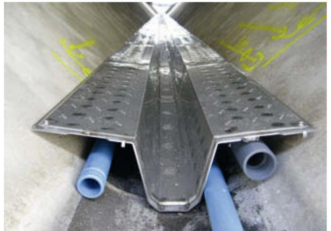
Abb. 3: Wärmetauscherelemente (Firma Uhrig) während der Installation in der Schlangennrinne (Drachprofil) (Foto: Jan Butz, Klinger und Partner)
