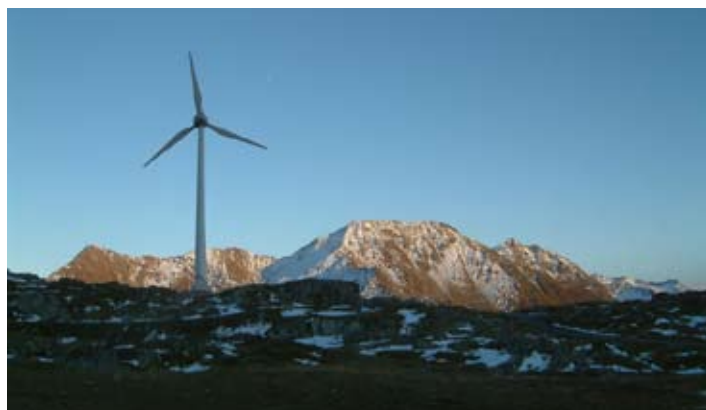
Gütsch: Ausbau mit Hindernissen
