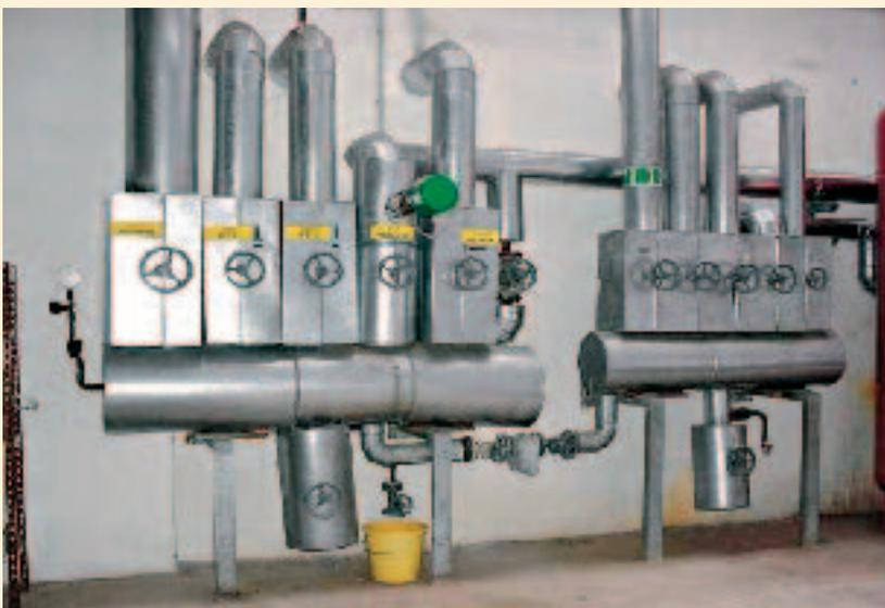
*Vorbildliche Wärmedämmung an Leitungen und Armaturen des Warmwassernetzes*
