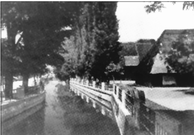
Erhaltenswerte Gebäude werden renoviert und umgenutzt.
