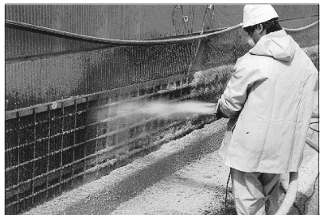
Bild 3.24 Einspritzen des Anodennetzes für die elektrochemische Realkalisierung
