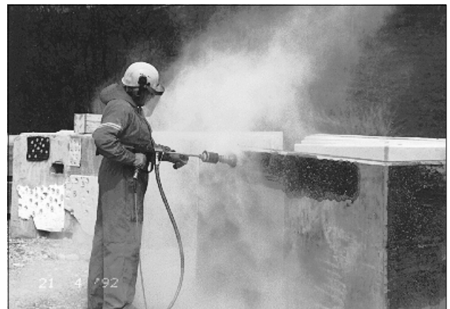
Bild 6.6 Höchstdruckwasserstrahlen mit Handlanze mit 2500 bar
