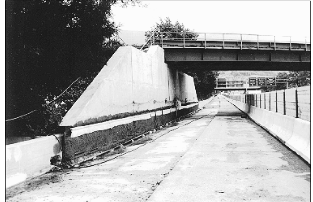
Bild 3.17 Widerlager während der Instandsetzung mit dem ECE-Verfahren
