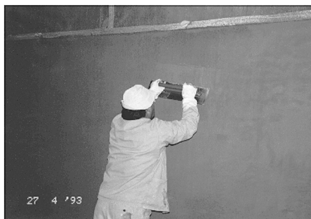
Bild 4.15 Nacharbeiten einer gespritzten Dickbeschichtung von Hand
