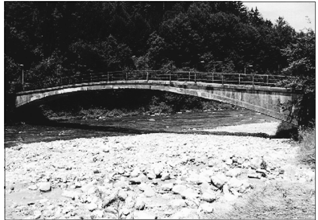
Bild 1.1 Stahlbetonbrücke der ältesten Generation über die Sihl
