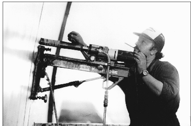
Bild 1.11 Schäden können durch eine Inspektion frühzeitig entdeckt werden
