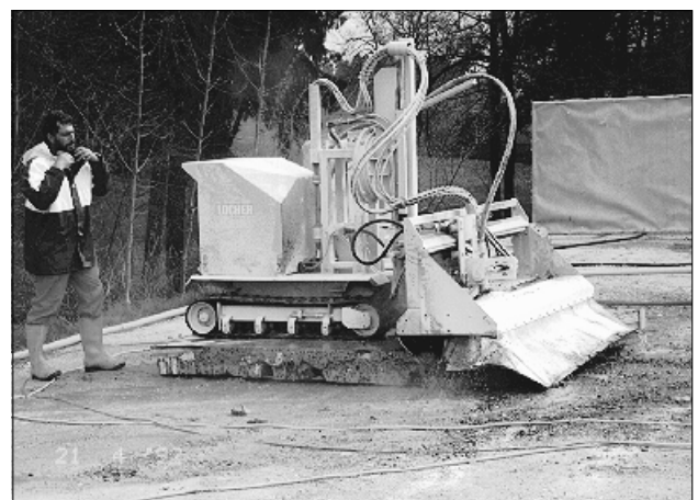
Bild 6.7 Hochdruckwasserstrahlen mit Roboter mit 1000 bar
