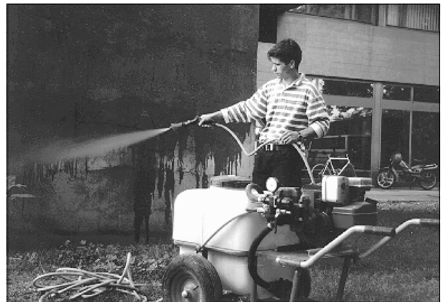
Bild 3.27 Applikation des Inhibitors an einer Fassade
