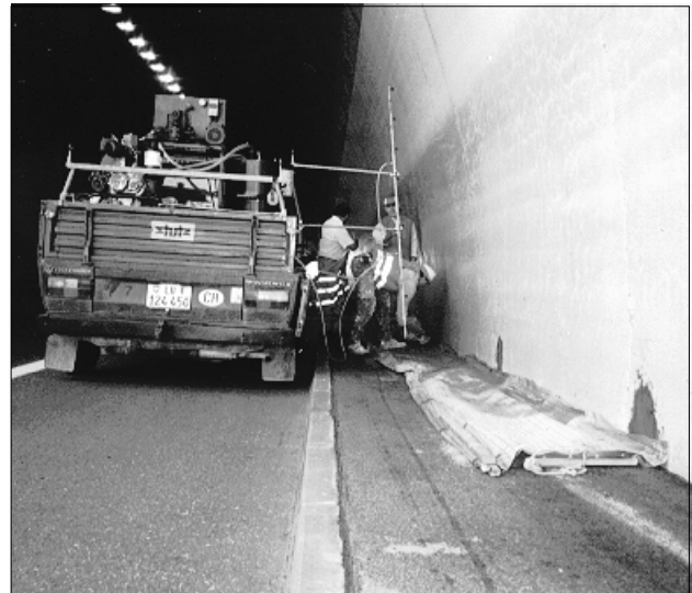
Bild 4.9 Applikation einer Hydrophobierung mittels Sprühgerät
