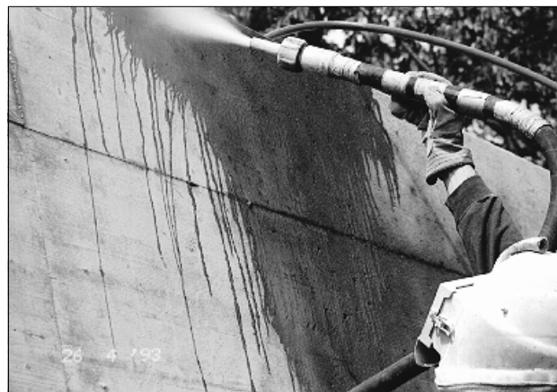
Bild 6.4 Wassersandstrahlen, keine Staubentwicklung, Wasser fließt über Betonoberfläche ab
