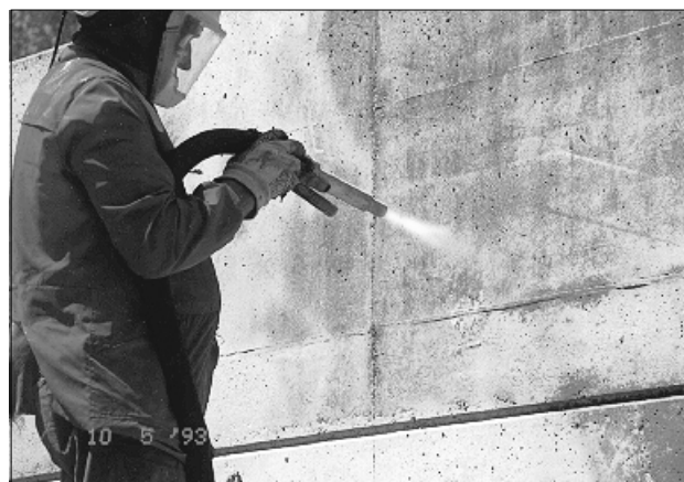
Bild 6.5 Feuchtsandstrahlen, keine Staubentwicklung, Betonoberfläche wird nur leicht feucht
