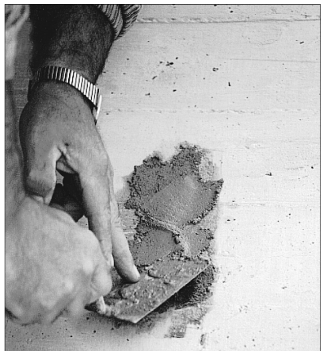
Bild 3.11 Lokale Reprofilierung mit Reprofiliermörtel
