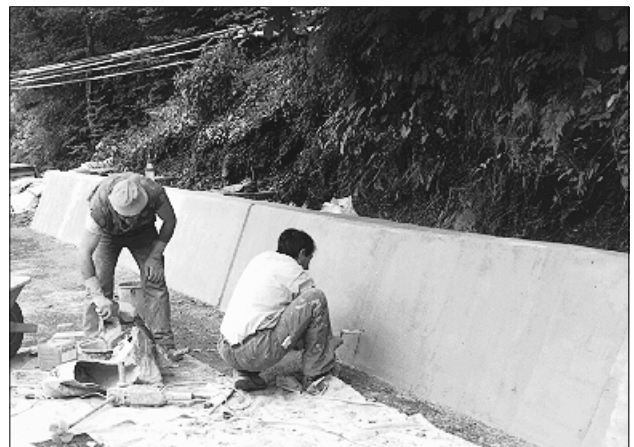
Bild 3.10 Auftragen einer Spachtelung als Poren-/Lunkerverschluss von Hand
