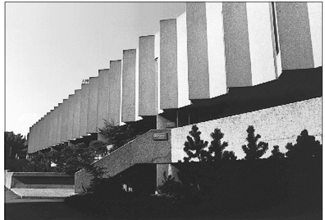
Bild 3.25 Beispiel einer mit MFP behandelten Fassade
