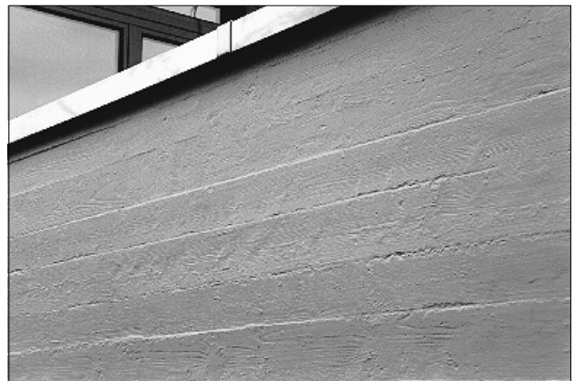
Bild 4.11 Mit 4% Pigmentzusatz versiegelte Betonoberfläche
