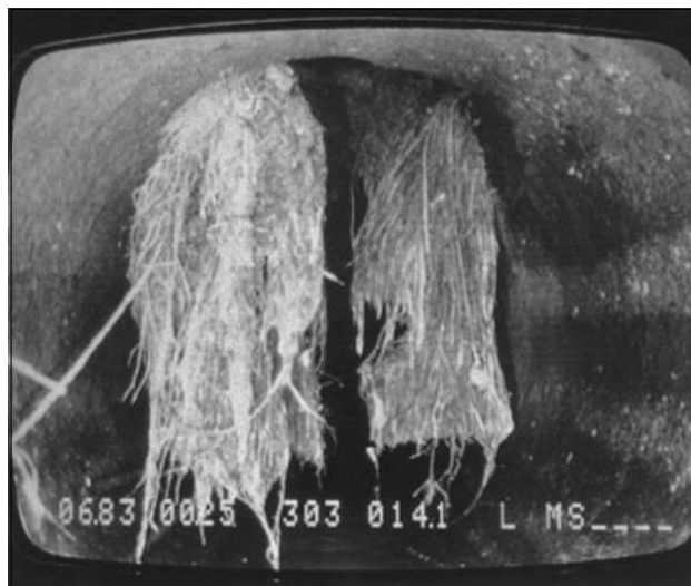
Abb. 3.16 Wurzeleinwüchse erfordern einen erhöhten betrieblichen Unterhalt.
