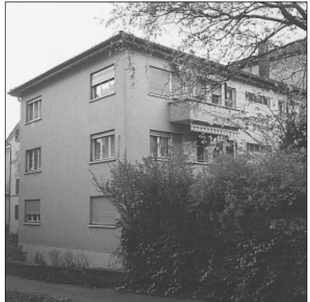
Foto 4.2 Süd- und Ostfassade
