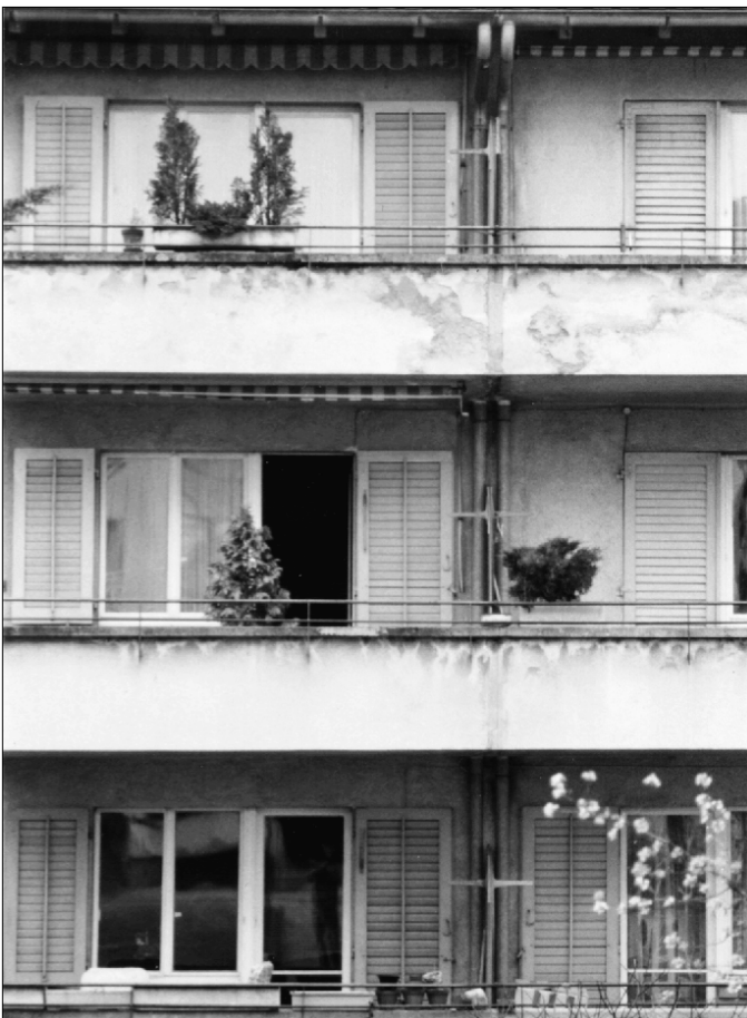
53 Mittlere Balkonpartien mit erheblichen Witterungsschäden. Süd-West-Fassade
