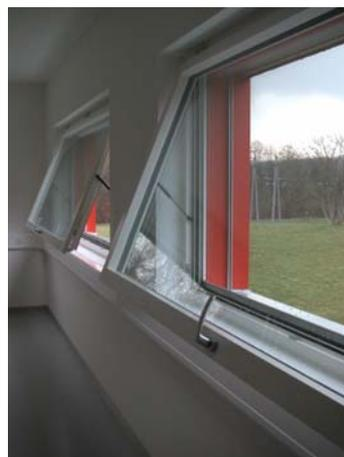
Abbildungen 7: Einflügelfenster mit neuartiger Hebevorrichtung
