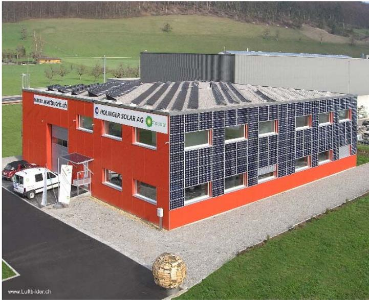
Abbildung 1: Westansicht WATTWERK mit integrierter 12 kWp- Fotovoltaik-Anlage in Südwestfassade
