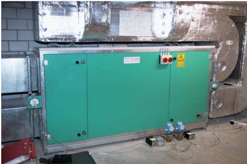
Abbildung 6-17 : Zentrales Lüftungsgerät im P+D Passivhaus Stans
