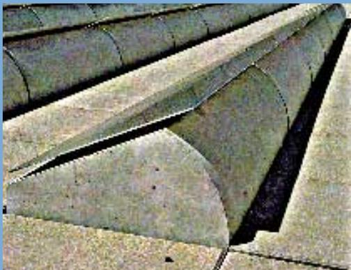
**Umsetzungs-Beispiel PV-Elemente für Flachdächer:** Je ein PV-Modul von 120 cm Länge und 52 cm Breite liegt auf zwei Betonsockeln auf. Das Gewicht der Sockel allein garantiert ausreichende Standsicherheit gegenüber Windkräften.
