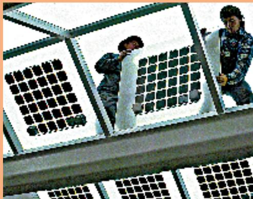
Eine Gebäudeintegration von photovoltaischen Solarzellen mit gleichzeitiger Tageslichtnutzung ermöglichen diese lichtdurchlässigen Dachplatten, in welche die Solarzellen eingelassen sind.
