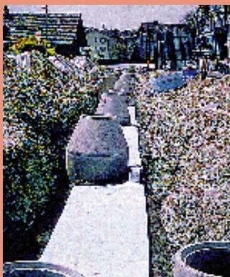
Abwärmespeicherung für Überbauung in Buchrain mit 19 je 200 m tiefen Erdwärmesonden (2 je Schacht, längs 3 wärmegeämmte Sammelleitungen).
