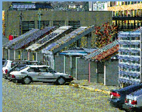
Internationale Zusammenarbeit in der **Photovoltaik**: An der ETH Lausanne werden in einem IEA-Projekt PV-Anlagen nebeneinander betrieben, um die Integration in Gebäuden zu demonstrieren.
