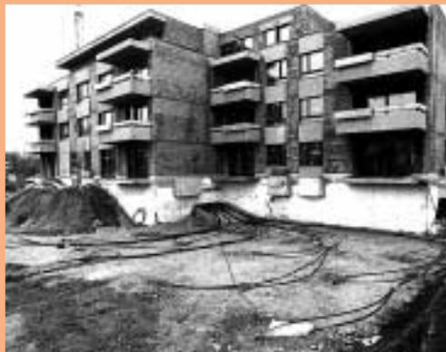
Ein Dutzend Erdwärmesonden zur Heizung eines Mehrfamilienhauses ist schon in die Bohrungen abgesenkt. Vor der Überdeckung liegen die Rohrstränge zur Wärmepumpe im Keller noch offen.
