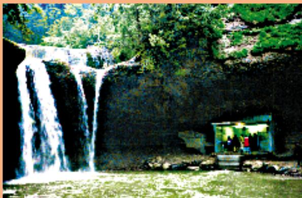
110-kW-Kleinwasserkraftwerk am Gonzenbach im Guggenloch, Toggenburg, 1996 mit Umweltschutzmassnahmen wiederbelebt: Erhaltung der Stauwehr aus dem Jahr 1894 (links oben), Druckleitung unterirdisch, Maschinenhaus (rechts) mit Schallschutzverglasung.
