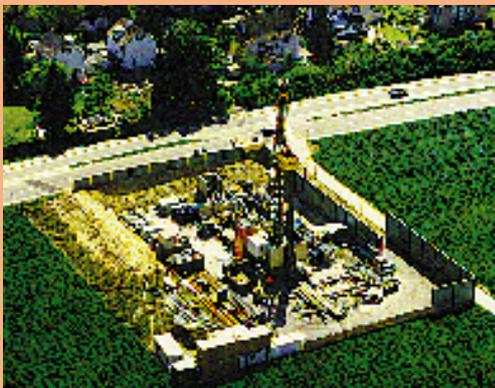
Bei der geothermischen Tiefbohranlage in Reinach, BL, schützten Lärmschutzwände und -wälle die Anwohner vor dem Bohrlärm. Nach Abschluss der Arbeiten wurde der ursprüngliche Zustand wiederhergestellt.
