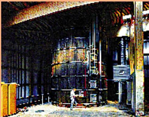
Das Kompostier- und Vergärwerk in Baar setzt jährlich 18.000 t Bioabfälle um. Das neuartige, energieautarke Verfahren liefert sogar Stromüberschuss und ist dank einem Biofilter (im Bild) zur Abluftreinigung abwasserfrei.
