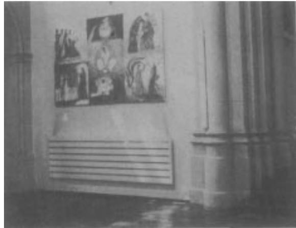
Es werden auch Niedertemperatur Direktheizgeräte in kompakter Flachbauweise als sogenannte Strahlungswände hergestellt.
