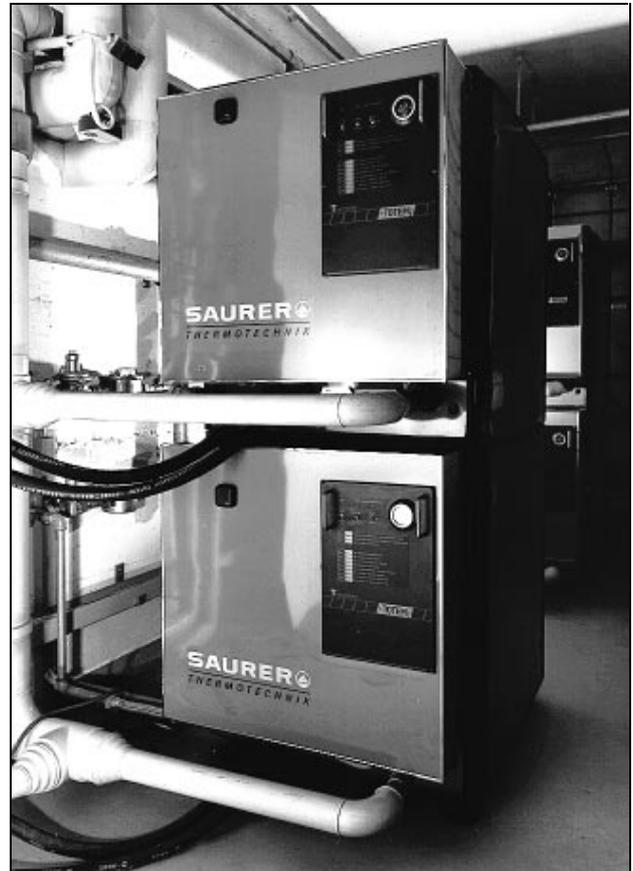
Bild 22: Vier Klein-Blockheizkraftwerke mit 4 x 15 kW elektrischer Leistung geben zusammen eine Heizleistung von 156 kW ab
