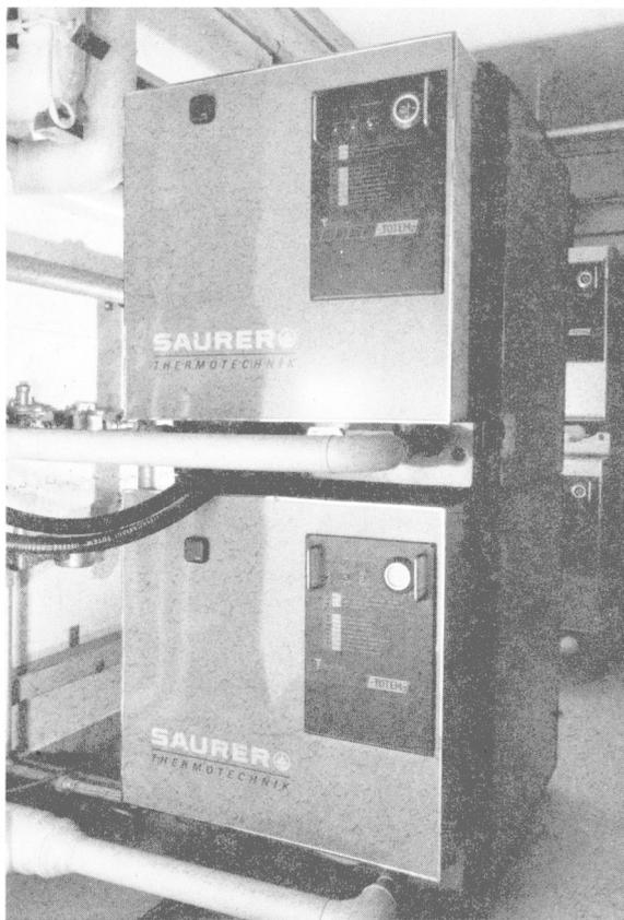
**Bild 25** Vier Klein-Blockheizkraftwerke mit 4 x 15 kW elektrischer Leistung geben zusammen eine Heizleistung von 156 kW ab
