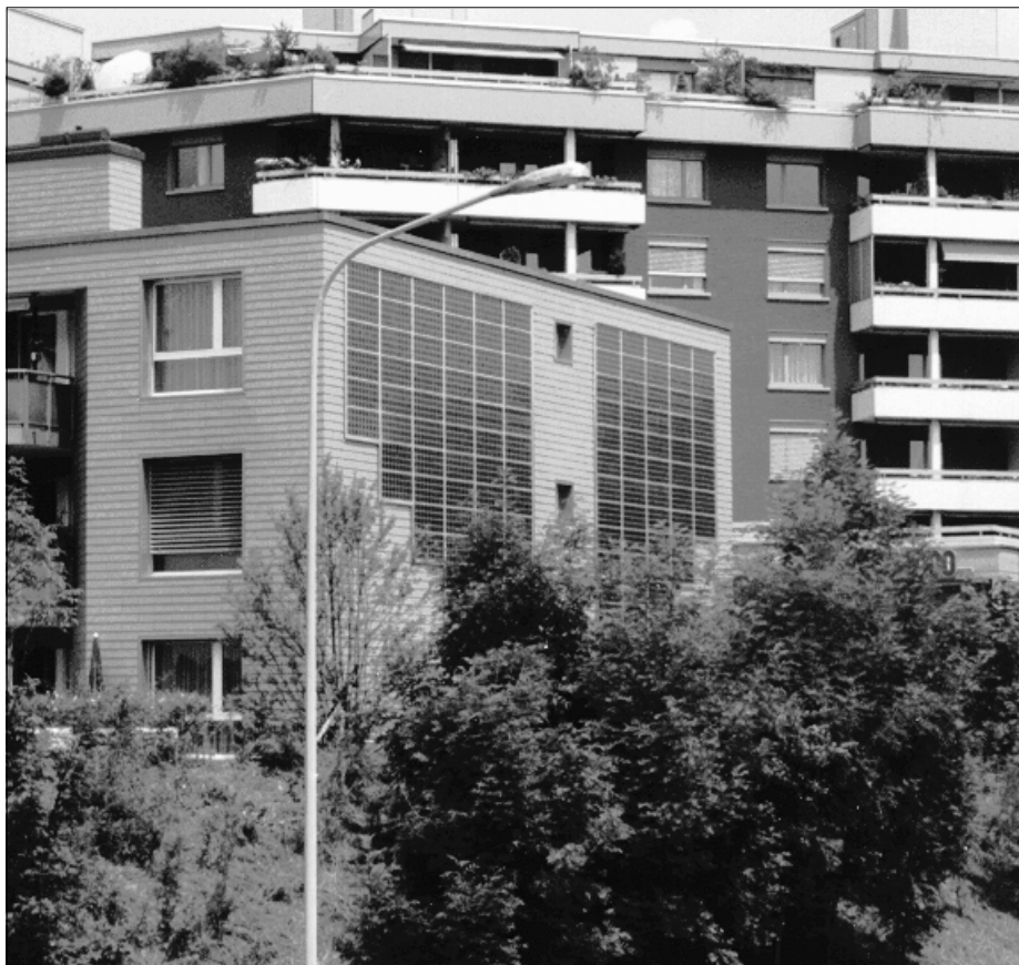
Beispiel: Solarfassade (6 kW)
