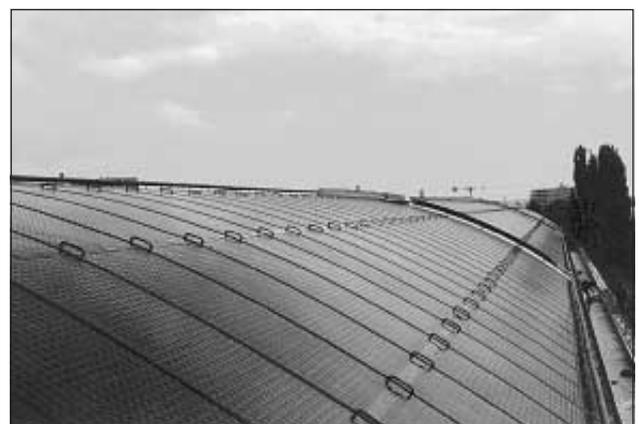
Eine zusätzliche Reduktion der Kosten wird durch die Weiterentwicklung der unverglasten selektiven Kollektoren zu eigentlichen Dach- bzw. Fassaden-elementen angestrebt, die neben der Sonnenenergienutzung auch die Funktion der Gebäude-Aussenhaut (Wetterschutz) vollständig übernehmen.
