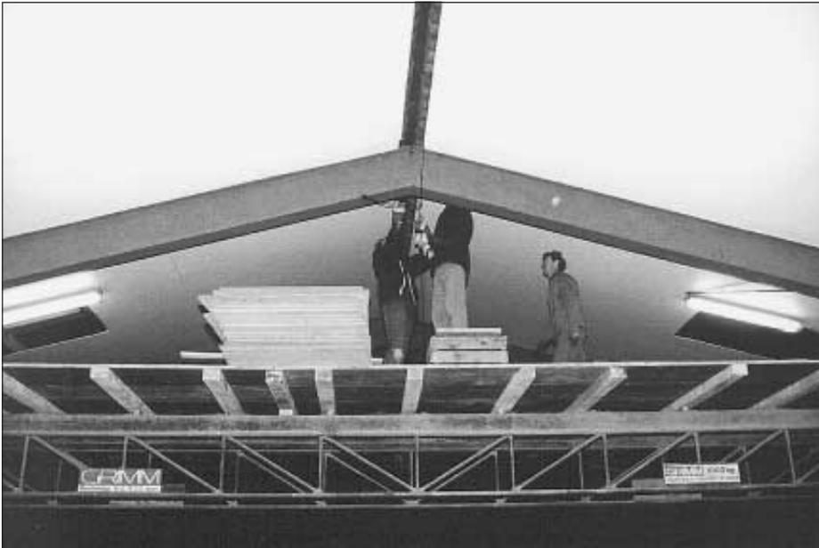
Diese Arbeitsweise ist wohl praktisch, jedoch viel zu gefährlich. Das Arbeitspodest könnte sehr leicht durch ein Geländer gesichert werden. Anstelle von Schaltafeln sind Gerüstbretter zu verwenden. Bei Binder mit Untergurt oder Zugstange kann der Greifer nicht eingesetzt werden.
