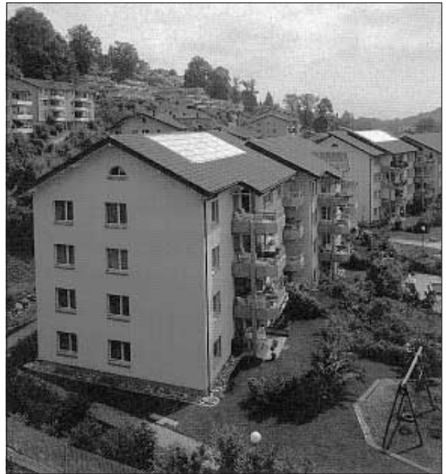
Sonnenkollektoren auf den Dächern der Mehrfamilienhäuser Mittlerhusweg, Kriens
