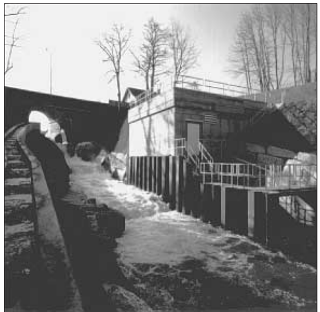
Zentrale. Von links: Fischpass, Langeten, Unterwasserkanal
