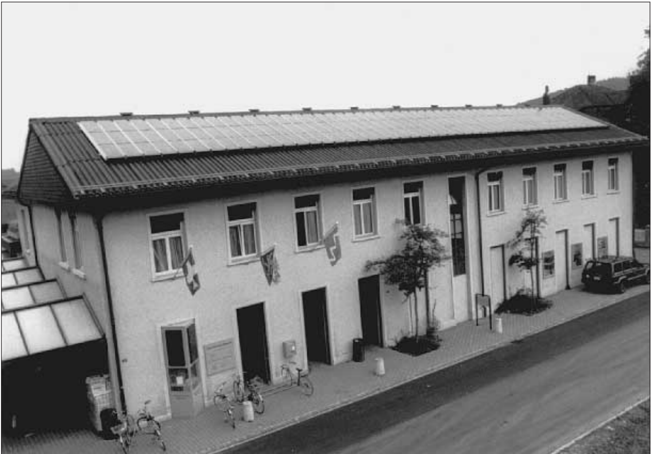
83.5 m 2 Solarzellen sind auf dem Dach der Entress-Liegenschaft an der Wiesentalstrasse in Aadorf installiert.
