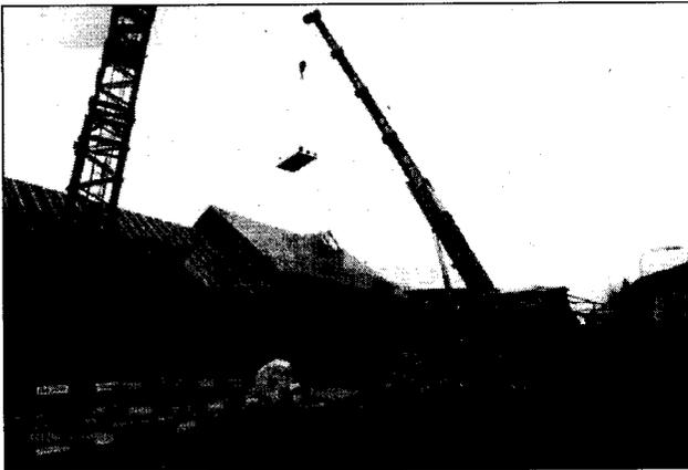
Einbringen der Kesselteile in die Heizzentrale mittels Pneukran
