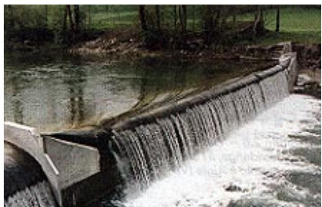
Abbildung 2.4: Beispiel eines Schlauchwehres an der Ilfis in Bärau bei Langnau (BE)
