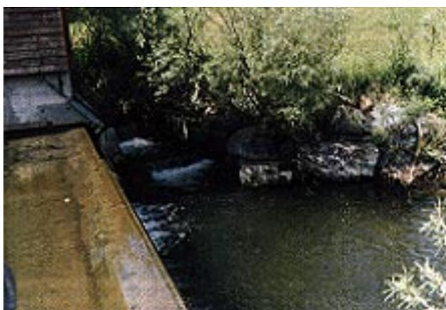
Abbildung 3.6: Einstieg in den Umleitungsbach unterhalb des Wehres bei einem Kleinstwasserkraftwerk in Kleindietwil (BE)
