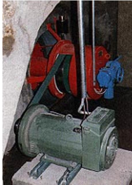
Abbildung 4.2b: Turbine mit Synchron-generator im Betrieb
