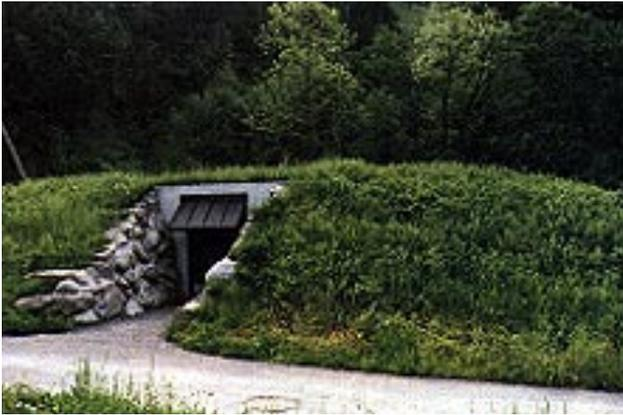
Abbildung 3.8: Zentrale des Kleinstwasserkraftwerkes (250 kW) von Le Pont de la Tine (VD): bis auf den Eingang vollständig erdüberdeckt
