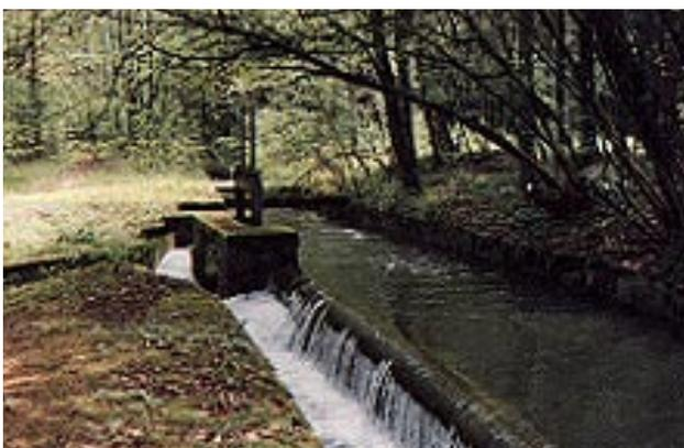
Abbildung 2.6: Sandfang mit Entlastungsbauwerk (Streichwehr) und Spülschütz eines Kleinstwasserkraftwerkes in Aigle (VD)
