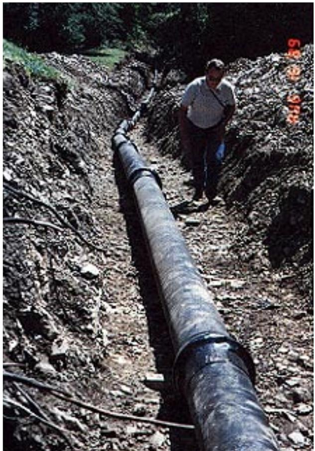
Abbildung 2.8: Druckleitung aus Guss bei der Verlegung im Rohrgraben (KWKW der Gemeinde Brienzwiler, BE)
