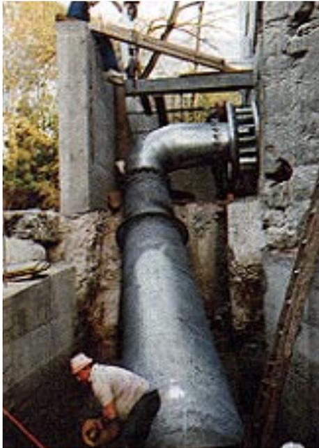
Abbildung 4.2a: Montage der Kaplan-Turbine mit Saugrohr
