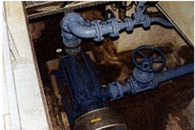
Abbildung 7.4: Turbine in der Wasserversorgung: Umkehrpumpe mit By-pass und automatischer Klappe
