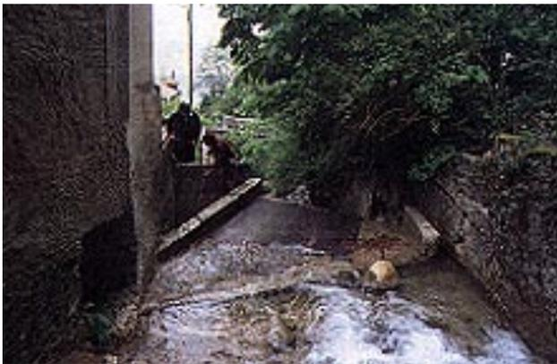
Abbildung 2.5: Beispiel eines Tirolerwehrs mit Lochblech eines Kleinstwasserkraftwerkes an der Baumine bei Baulmes (VD)
