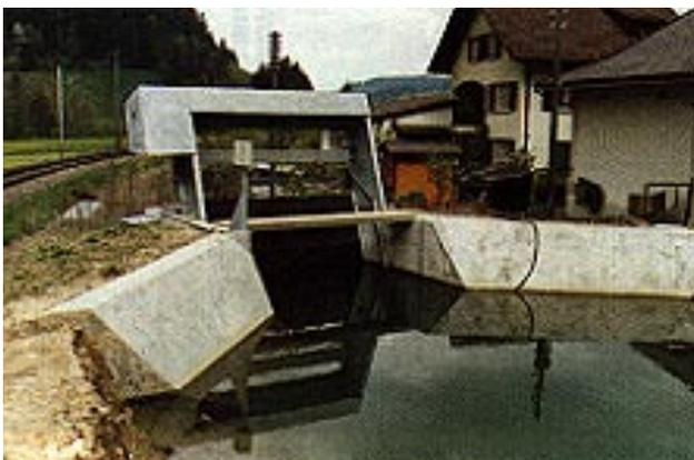
Abbildung 4.3: Rechenanlage mit automatischer Reinigungsmaschine
