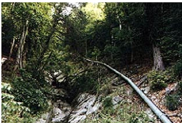
Abbildung 4.7: Druckleitung aus Stahl im steilen, felsigen Gelände oberirdisch verlegt
