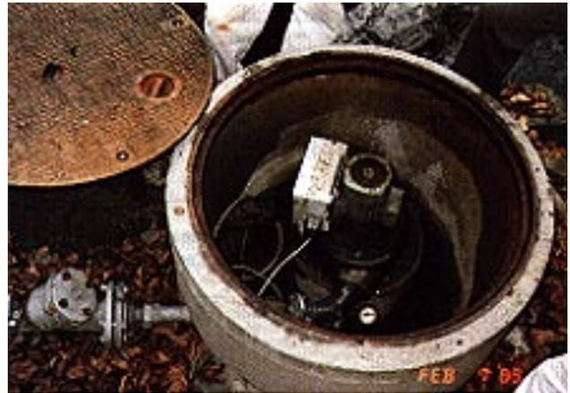
Abbildung 7.1: Im Eigenbau erstellte Kleinanlage (250 W) zum Laden von Batterien in der Nähe von Lausanne
