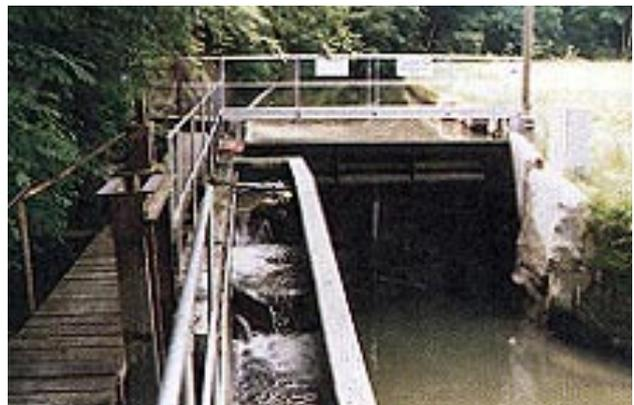
Abbildung 2.3: Beispiel einer Seitenentnahme mit Aufstau mittels beweglicher Wehrklappe: Kleinstwasserkraftwerk am Rothbach bei Huttwil (BE)
