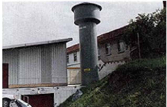
Abbildung 4.4: Wasserschloss aus Kunststoff
