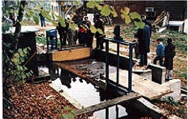
Abbildung 2.7: Entfernung des Geschwemmsels mittels selbstreinigendem Tirolerwehr mit Lochblech im KWKW der Mühle von Bavois (VD)
