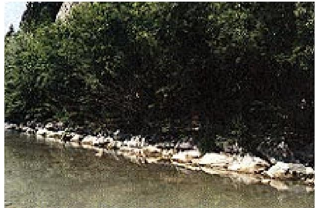
Abbildung 3.2b): Gleicher Verbauungstyp wie Abb. 3.2 a) jedoch 4 Jahre nach der Erstellung
