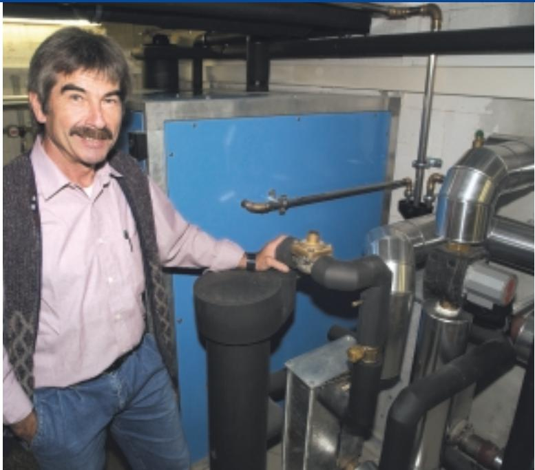
Als schwierig gelten auch Sanierungen, bei denen hohe Heizwassertemperaturen erzeugt werden müssen. Im Riedtlihof sind an den kältesten Wintertagen über 70 Grad nötig. Ideal sind in solchen Fällen bivalente Anlagen: Die Wärmepumpe bringt das Heizwasser beispielsweise auf 55 Grad, ein zusätzlich installierter Heizkessel heizt es weiter auf.
