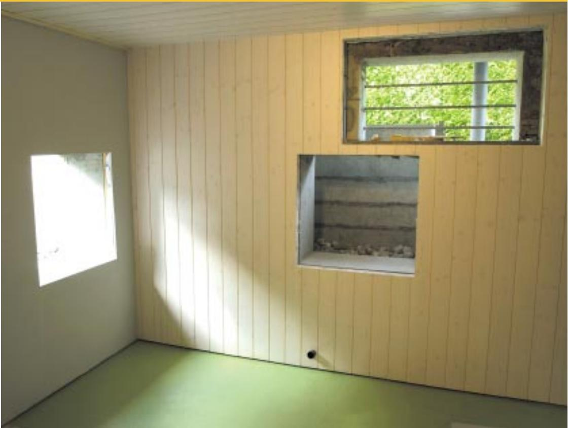
Bis vor Kurzem lagerten hier noch 7'000 Liter Heizöl, nun wird der Raum für die Installation der Luft/Wasser-Wärmepumpe vorbereitet. Links die Öffnung für den Luft-Ansaugkanal, rechts unterhalb des Fensters die Ausblasöffnung. Da Wärmepumpe und Speicher nur wenig Platz in Anspruch nehmen, gibt's im alten Heizraum Platz für das Überwintern von Pflanzen und er dient auch als Abstellraum für Velos.
