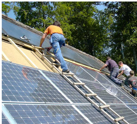
Montage einer Sonnenkollektoranlage fürs Warmwasser und einer Photovoltaikanlage für die Stromerzeugung
