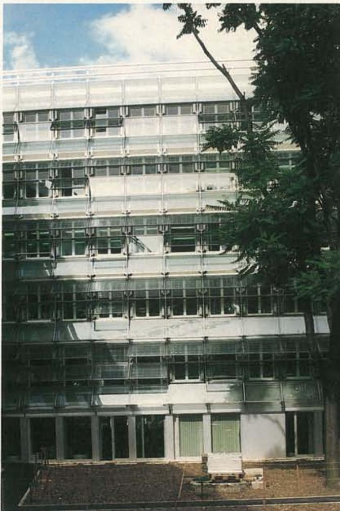
Der bestehenden, massiven Fassade wurde eine transparente Glashülle vorgesetzt. Sämtliche Glaselemente sind beweglich. Sie richten sich nach dem Sonnenstand, der Witterung, der Jahreszeit und den Bedürfnissen der Benutzer. Jedes der drei Glasfelder, die ein Geschoss unterteilen, erfüllt eine andere Funktion:
