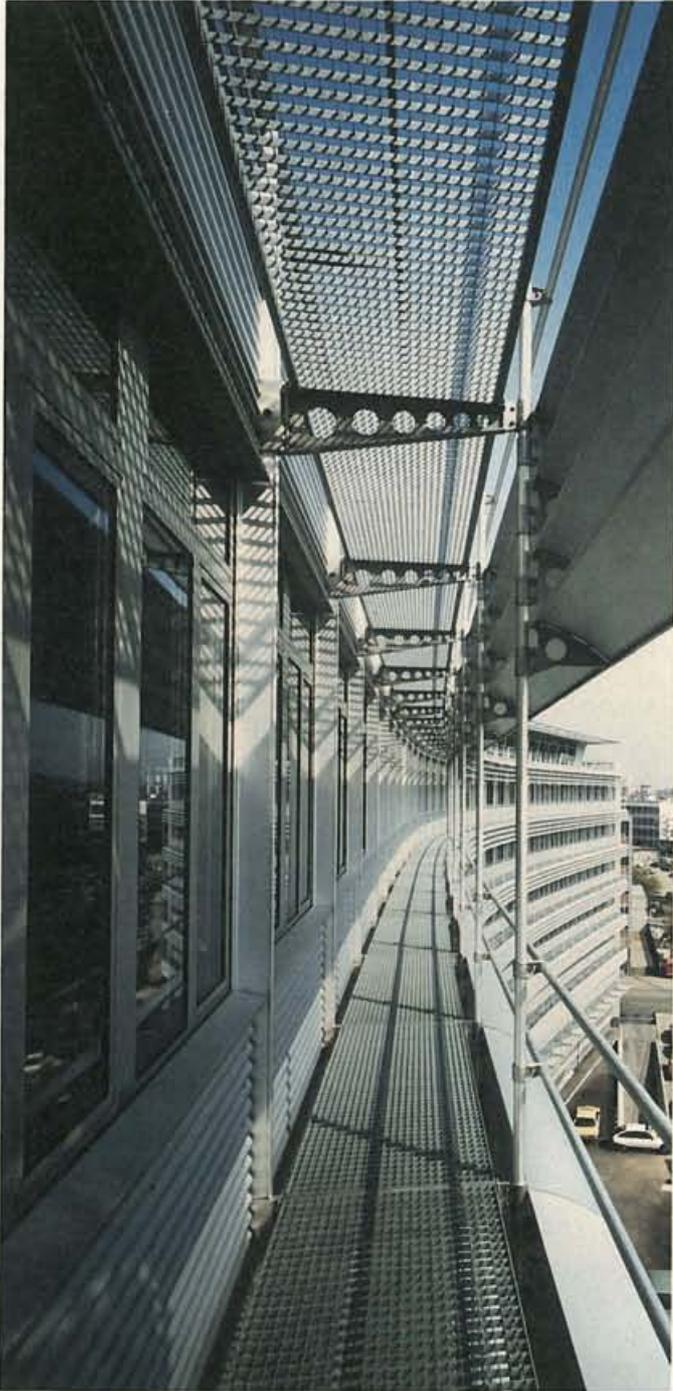
Wartungsgang mit vorgehängten Lamellen
