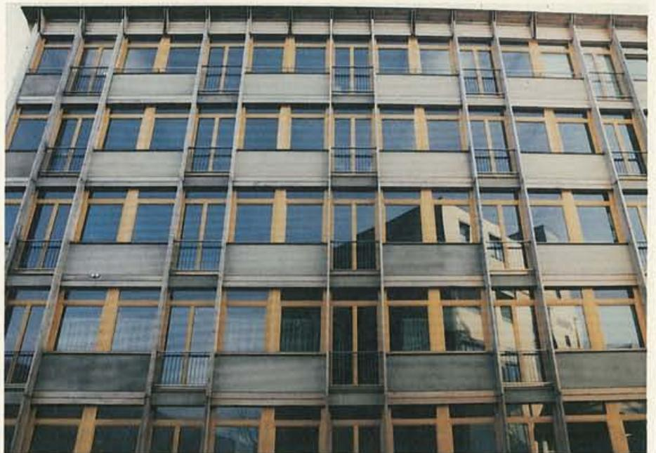
An der Nordfassade wird das seitliche Streiflicht durch vertikale, vorstehende Holzlamellen abgehalten. Bürohaus, Liestal BL
