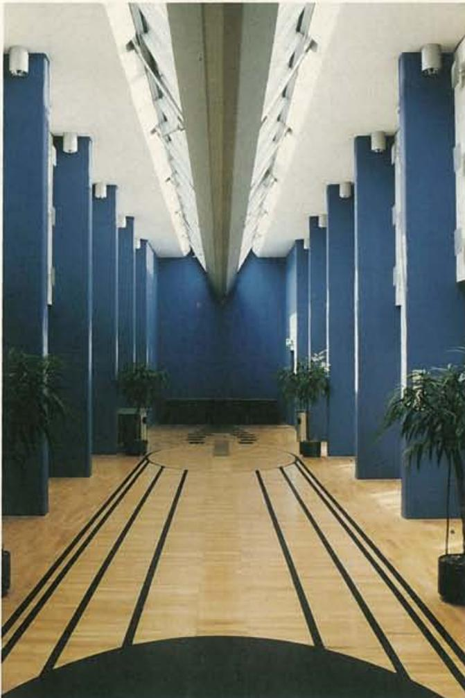
Ein Gang im Untergeschoss erhält durch ein Oberlicht viel Tageslicht. Ungewöhnlicherweise zeigt das im Schnitt dreieckige Lichtband mit der Spitze nach unten. Die Öffnung im Boden wird von einem flachen, begehbaren Gitterrost überdeckt. Der öffentliche Bereich, unter dem der Gang liegt, wird dadurch optisch und flächenmässig nicht eingeschränkt.
