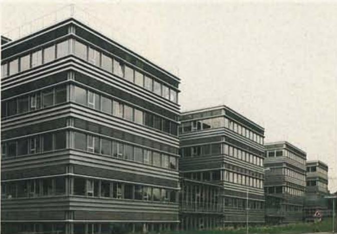
Rundung von Fassaden, Auffächerung der Baukörper und Versetzung von Dachflächen sind die Möglichkeiten, die Oberfläche eines Gebäudes zu vergrössern. Dadurch erhöht sich der Anteil der Aussenfläche, die für die Aufnahme von Tageslicht genutzt werden kann.
