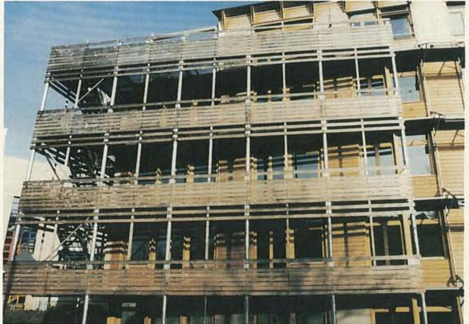
Der vorgesetzte Laubengang an der Westfassade dient als Wetterschutz und filtert die tiefe Sonneneinstrahlung.
