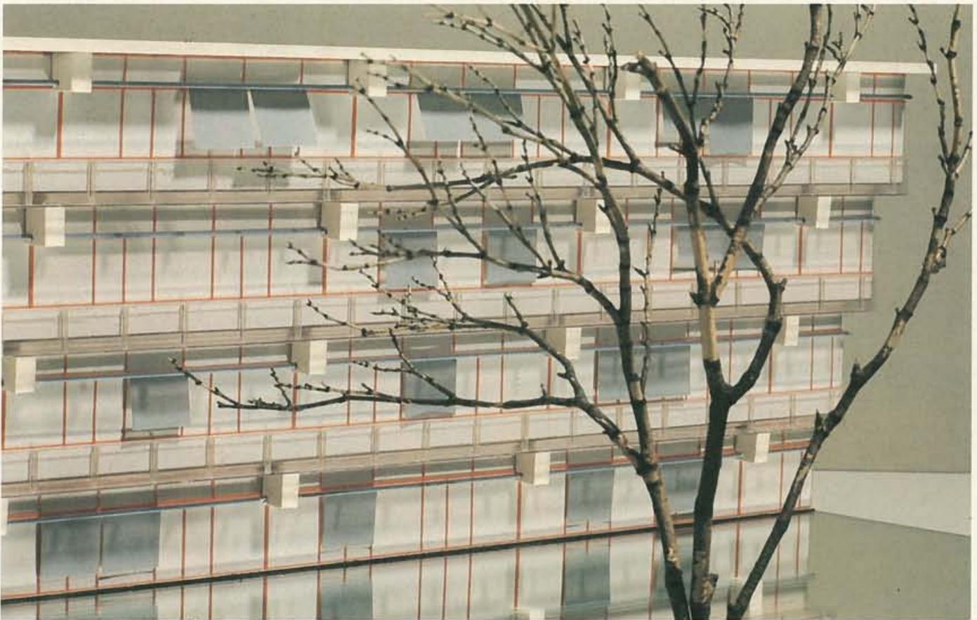
Die viergeschossige tageslichtkonforme Fassade spiegelt sich im vorgelagerten Bassin. Auf der Grünböschung wachsen Bäume. Der grosse 8,00 m Raster ist durch die Tragkonsolen ablesbar. Der Schatten der geschossweiten Vorkragung kann durch individuell bediente Storen ergänzt werden.
