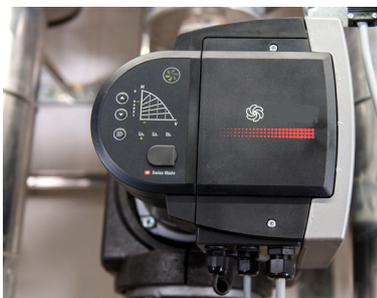
Bei neueren Pumpen kann der Volumenstrom über diverse Funktionen eingestellt werden (z. B. automatisch, über Proportionaldruck-Kennlinie
