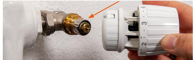
Beispiel eines blockierten Ventilstiftes (siehe Pfeil), der sanft mit einem Gummihammer gelöst werden kann. Der Stift sollte keinesfalls manuell herausgezogen werden.
