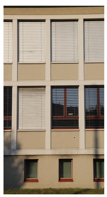
Werden die Storen geschlossen, verringern sich die solaren Wärmegewinne. 50 % der Fenster sind selbst an den kältesten Tagen verschattet, haben die VenTSol-Forschenden gezeigt. Foto: B. Vogel
