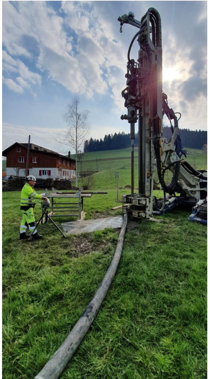
Erdwärmesonden werden 50 bis 300 m tief verlegt. Sie bestehen aus parallel verlaufenden Kunststoffrohren, in denen ein Gemisch aus Wasser und Frostschutzmittel (Sole) zirkuliert. Foto: LSS Bohr AG
