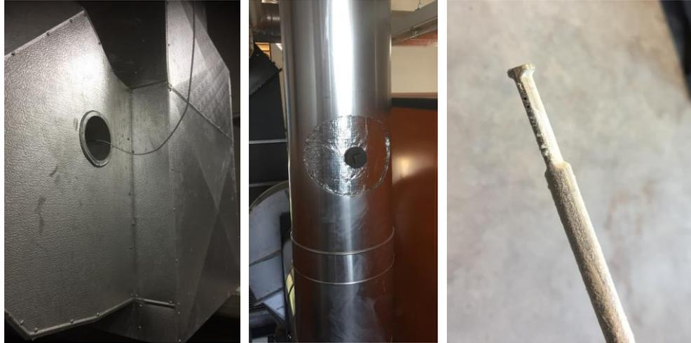
**Abbildung 1:** Temperaturmessung vor Kondensation (links), zusätzlich eingerichtete Messstelle für die Volumenstrommessung der Abgasrezirkulation (mitte), spezielles gerades Prandtl-Rohr für kleine Messöffnungen (rechts)
