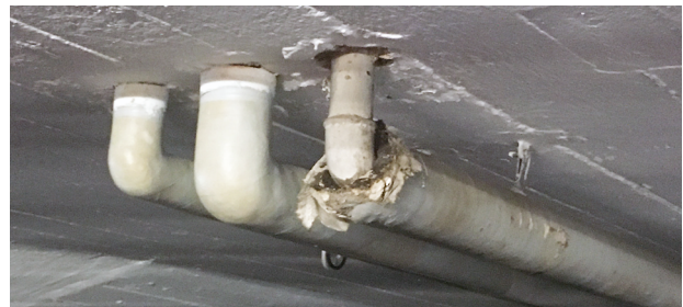
Defekte Wärmedämmungen reparieren.
