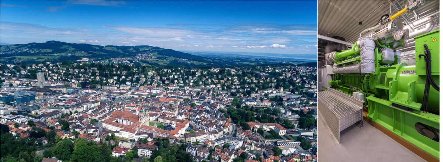
Die Stadt St. Gallen (Bild links) setzt Erdgas-befeuerte Blockheizkraftwerke ein, um Ölheizungen zu ersetzen und damit den Ausstoss von Treibhausgasen zu senken. Bild rechts: eines der beiden Blockheizkraftwerke der neuen Fernwärmezentrale Lukasmühle mit 2 MW Leistung zur Wärme- und Stromproduktion. Foto: Stadt St. Gallen / St. Galler Stadtwerke
