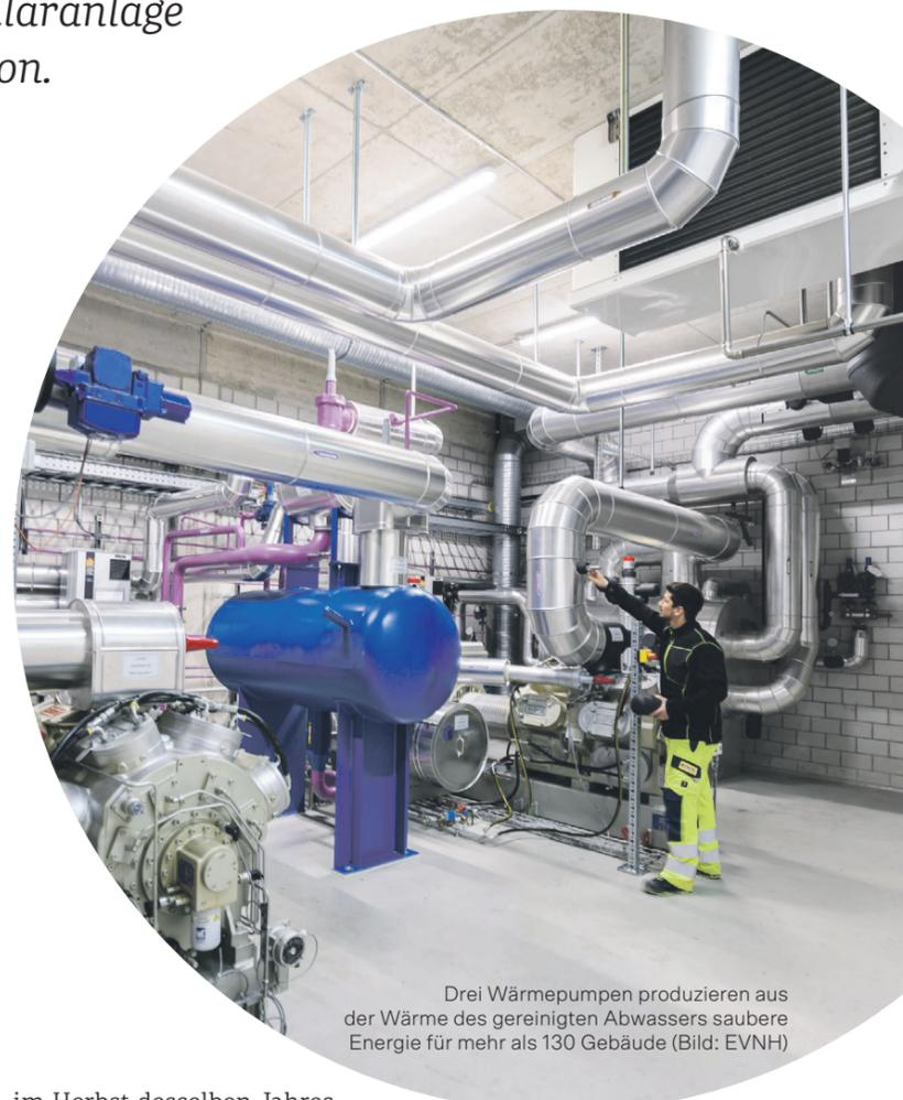
Drei Wärmepumpen produzieren aus der Wärme des gereinigten Abwassers saubere Energie für mehr als 130 Gebäude (Bild: EVNH)
