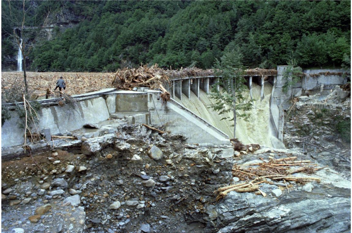
Abb. 1-1 Schwemmholzverklausung an der Staumauer Palagnedra (TI) im Jahr 1978 (Quelle: [1])
