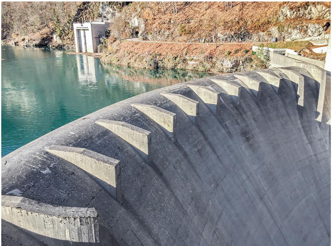
Abb. 1-2 Mauerüberfall der Staumauer Palagnedra im Jahr 2020 mit rückgebauten Brückenpfeilern
