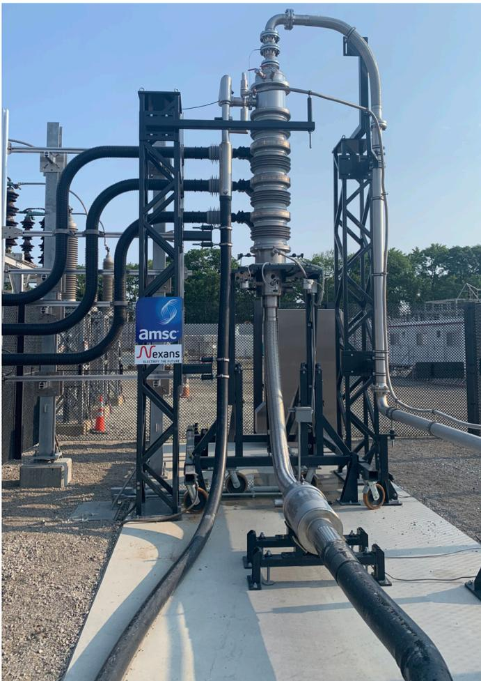
Bild vom Projekt eines HTS-Kabels in Chicago im US-Bundesstaat Illinois. Foto: AMSC
