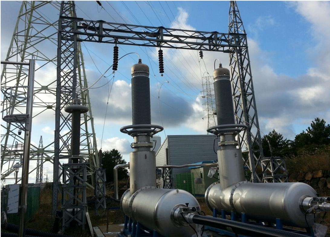
Endpunkt eines supraleitenden Gleichstrom-Kabels mit 80 kV Leistung in Südkorea. Foto: KEPCO
