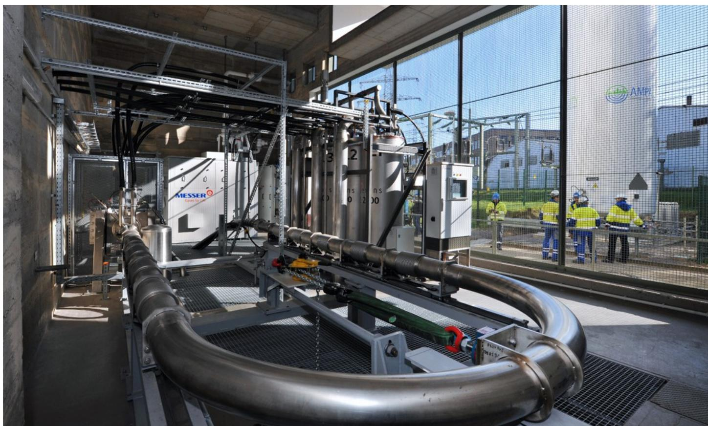
Foto der supraleitenden 10 kV-Stromleitung, die von April 2014 bis März 2021 in der Innenstadt von Essen (D) genutzt wurde. Das innovative Projekt fand in der Öffentlichkeit grosse Beachtung. Während den sieben Jahren erfolgte der Stromtransport fast ohne Unterbruch und annähernd störungsfrei, ein wirtschaftlicher Betrieb wurde während des Praxistests allerdings nicht erzielt. Rechts ausserhalb des Gebäudes steht der Tank mit der Kühlflüssigkeit Stickstoff. Foto: Westenergie AG
