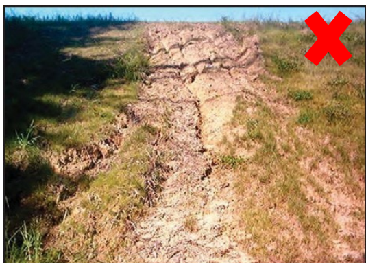
Oberflächenerosion (Bild: FEMA, 2016)
