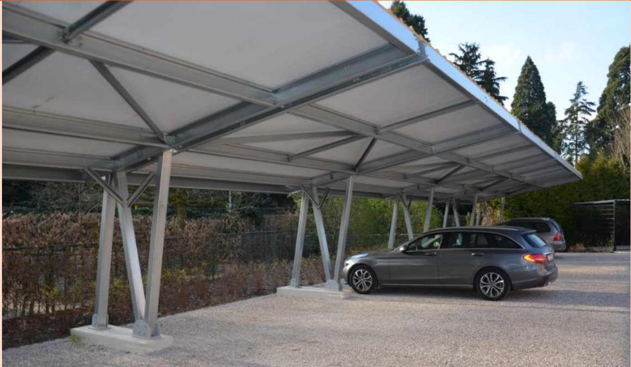
Abbildung 9: Carportstruktur von Mounting Solutions (© Mounting Solutions)
