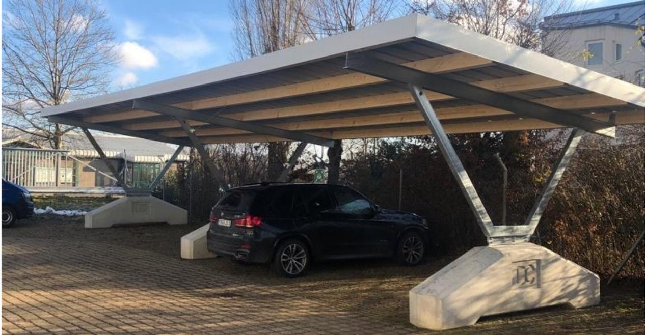
Abbildung 4: Solarcarport von DC Carport Systeme mit einem Gewicht von ca. 12 Tonnen. (© DC Carport Systeme)
