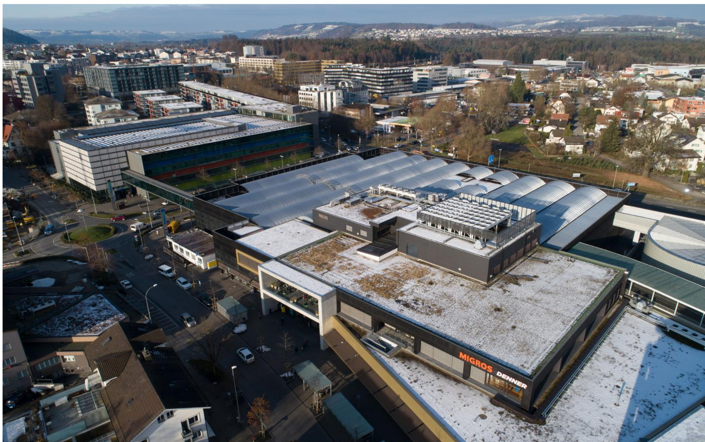
Das Migros-Einkaufszentrum Surseepark. Auf dem Dachaufbau rechts erkennt man die Wärmepumpen-Verdampfer bzw. Gaskühler der beiden CO<sub>2</sub>-Wärmepumpen, welche Wärme aus der Umgebungsluft aufnehmen (Heizbetrieb) bzw. Wärme an die Umgebung abgeben (Klimabetrieb). Aufgrund der geringen Lärmentwicklung können die Geräte auch in Wohngebieten betrieben werden. Aus optischen Gründen sind sie mit einem Sichtschutz versehen. Foto: Genossenschaft Migros Luzern
