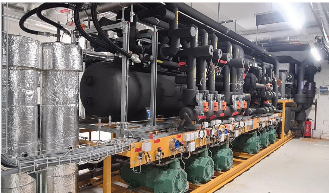
Blick auf eine der beiden reversiblen CO<sub>2</sub>-Wärmepumpen im Surseepark. Die Anlage hat eine Wärmeleistung von 550 kW und eine Klimaleistung von 630 kW. Foto: Genossenschaft Migros Luzern
