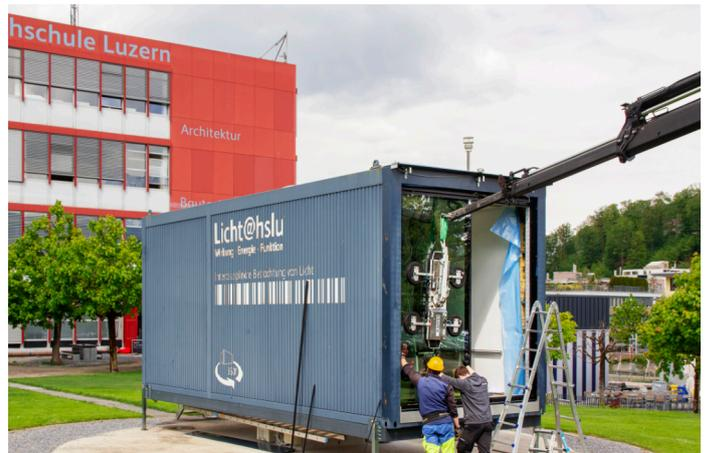
Der Lichtmesscontainer auf dem HSLU-Campus in Horw beim Einbau der elektrochromen Verglasung. Foto: Licht@hslu
