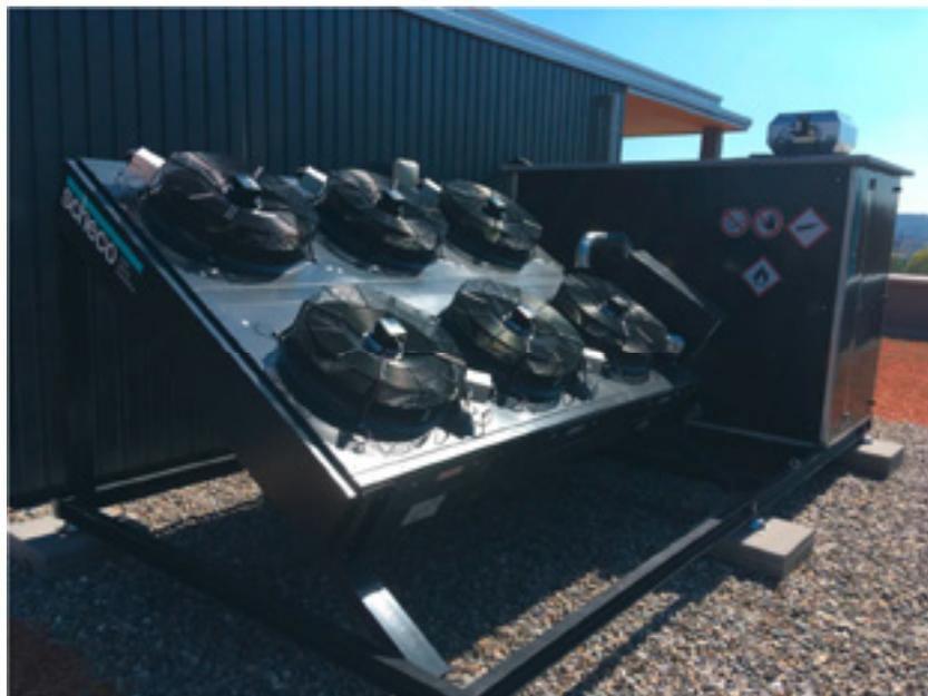
*Bild 3: Aufnahme der durch die Scheco AG entwickelten reversiblen Luft/Wasser-Wärmepumpe, welche mit dem natürlichen Kältemittel Propan betrieben wird.*
