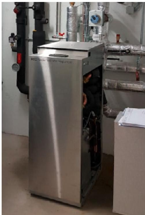
*Bild 6: Eingesetzte Niederhub-Wärmepumpe*
