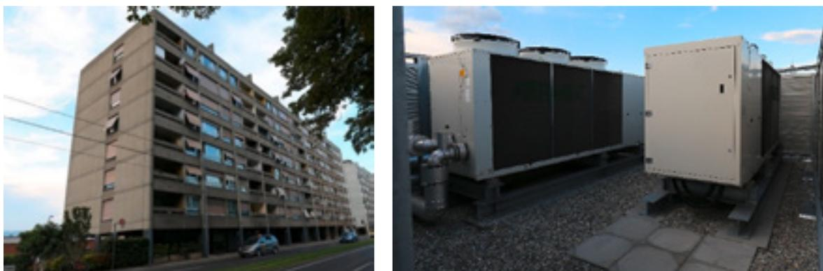
Figure 1. Bâtiment (à gauche) et pompes à chaleur industrielles air-eau en toiture (à droite).
