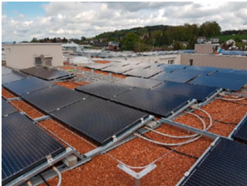
*Bild 7: Vorne PVT-Kollektoren auf dem Dach von Haus B, die drei hinteren Reihen sind ungedeckte, selektiv thermische Kollektoren der P&D-Anlage.*
