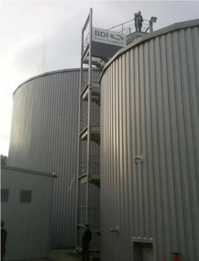
Abbildung 4: Kontaktverfahren zur Vergärung von Brauereiabwässern (Hauptfermenter hinten; Fermenter mit Schlammabscheider vorne) (Foto: BOKU, Wien)
