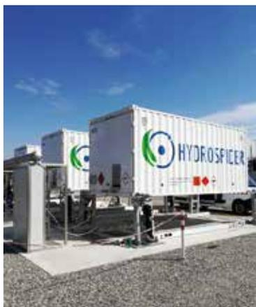
In 2020 geht eine 2 MW-Elektrolyseanlage von Hydrospider beim Laufwasserkraftwerk «Gösgen» in Betrieb zur Produktion von «grünem Wasserstoff» für Brennstoffzellen-LKWs. Das Bild zeigt Tankcontainern, wo produzierter Wasserstoff zwischengespeichert wird und die dazu dienen, die Tankstellen in der Schweiz mit Wasserstoff zu beliefern (Bildquelle: Hydrospider).
