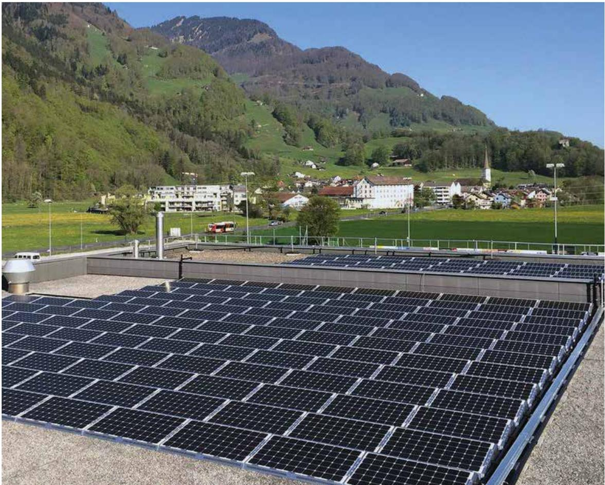
Hybride Photovoltaik-Thermie-Module (PVT) auf dem Dach der linth-arena sgu (Quelle: ZHAW).
