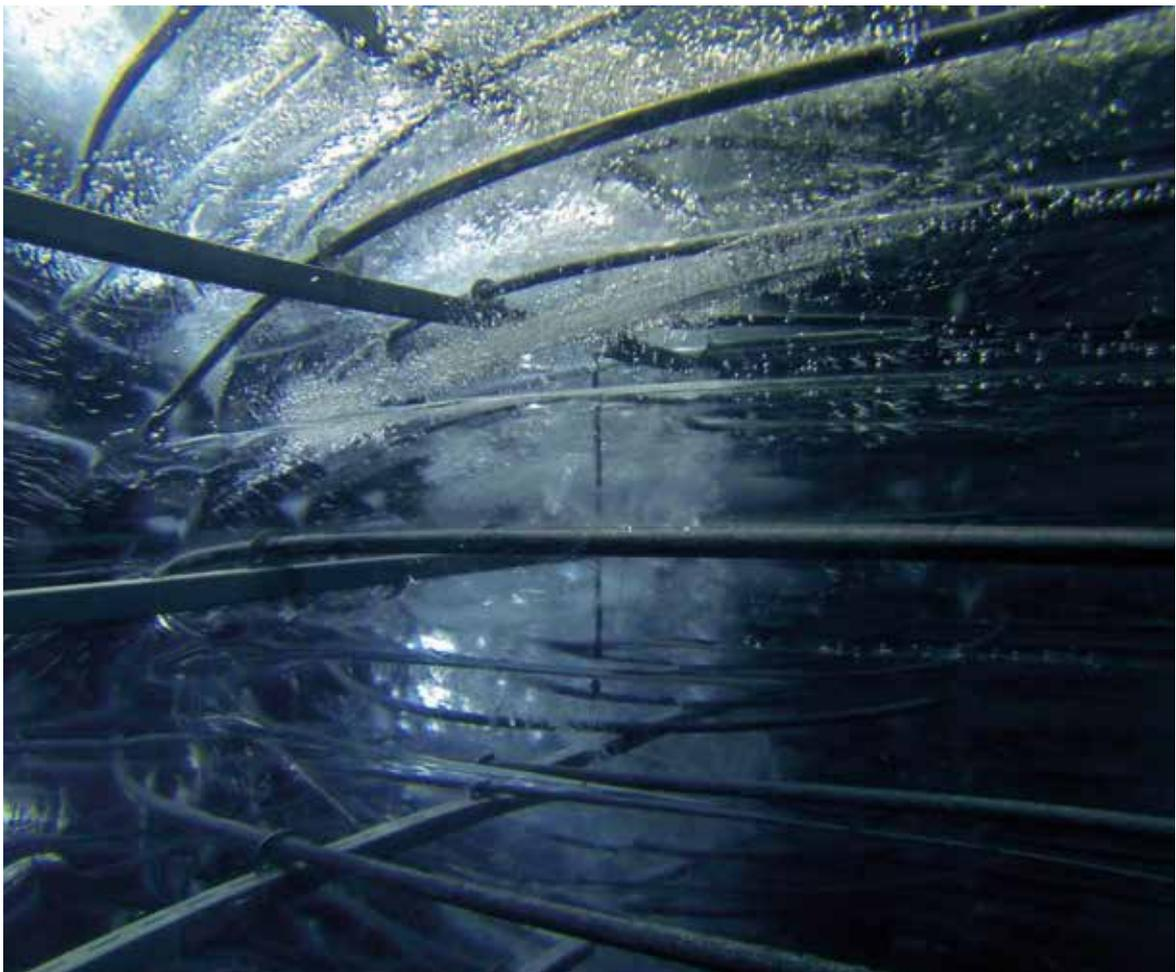
**Unterirdisches Eisspeicher-System mit einer Wärmesenken-Kapazität von 30 000 kWh. Eisspeicher sind Latentwärmespeicher mit Wasser als Speichermedium, wo die Latentwärme beim Phasenübergang von Eis zu Wasser und umgekehrt als Speicher genutzt wird. Im Temperaturbereich über 0 °C können diese auch als sensible Wärmespeicher dienen (Quelle: SCHNEPF Planungsgruppe Energietechnik, Nagold, Deutschland).**
