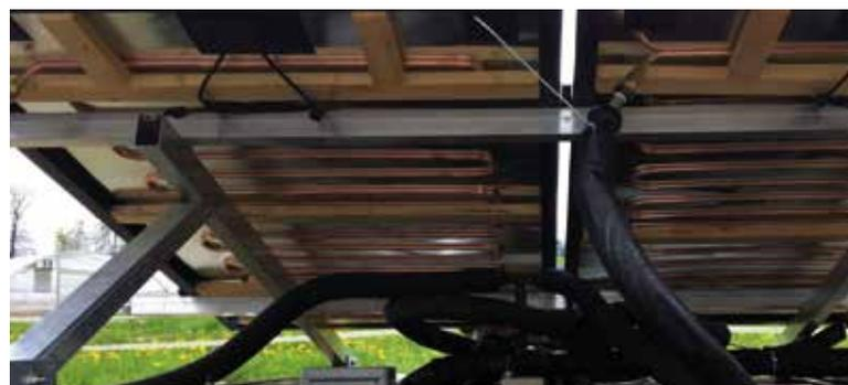
**Strom und Wärme für die Wärmepumpe:** Hier wurde ein herkömmliches PV-Modul nachträglich mit einem Wärmetauscher ausgerüstet (Quelle: ZHAW).
